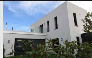
GR-38445 VOLOS (Thessaly) Freistehendes Einfamilienhaus
