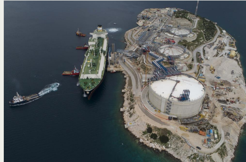
The Revithoussa LNG Terminal Station
