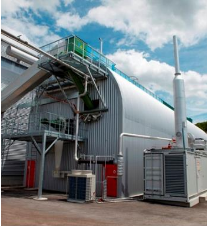
Μονάδα Βιολογικής Επεξεργασίας (Αναερόβια Χώνευση). ΜΕΑ Ηπείρου. Κατασκευαστής ΤΕΡΝΑ ΕΝΕΡΓΕΙΑΚΗ ΑΒΕΤΕ
