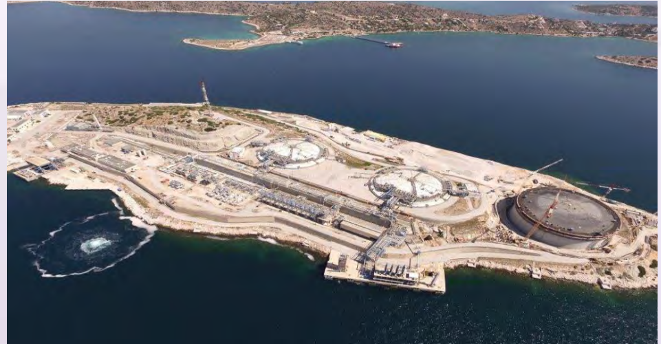
Εναέρια προσεγγιστική όψη τερματικού σταθμού νήσου Ρεβυθούσας με την εγκατάσταση της 3ης δεξαμενής (Πηγή: ΔΕΣΦΑ)
