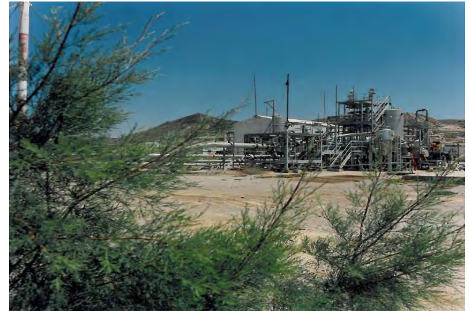
Πιλοτικός Γεωθερμοηλεκτρικός σταθμός Μήλου (2 MW, 1988, ΔΕΗ)
