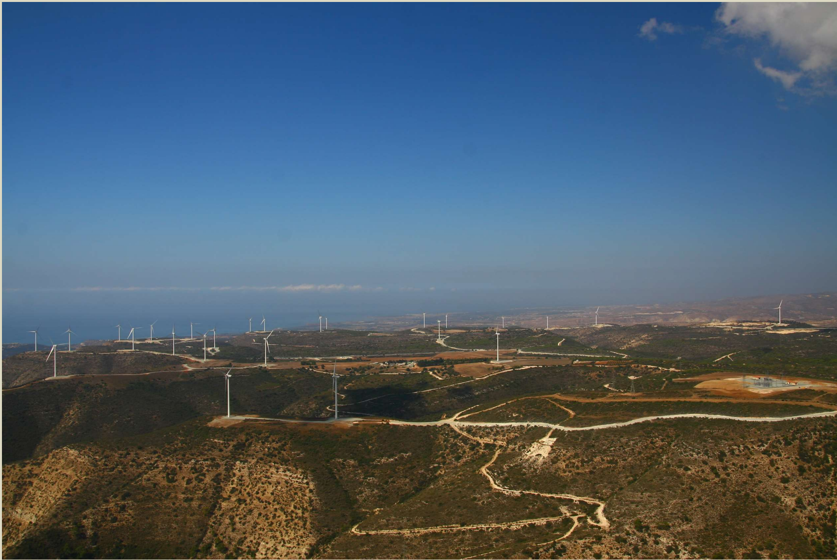
D.K. WINDSUPPLY LTD, Α/Π ΟΡΕΙΤΕΣ 82MW (ΠΑΦΟΣ), 7/2010 πλήρη λειτουργία
