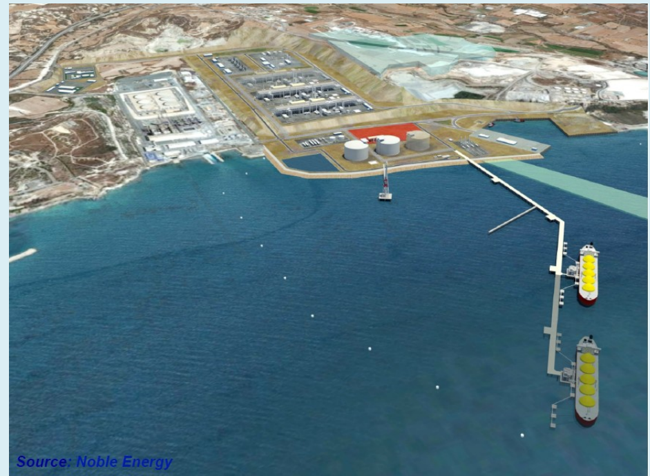
VASILIKOS LNG PLANT
